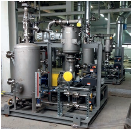
Abb 3: Vor dem Einbau
